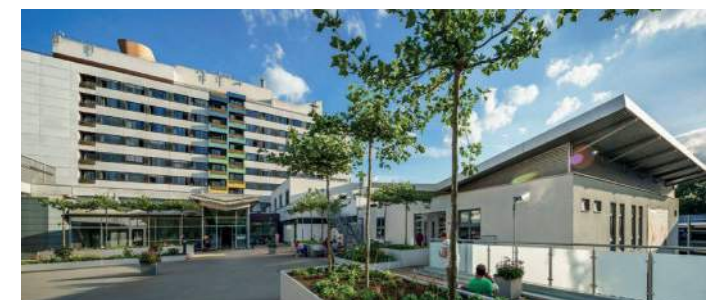
Marienhospital Gelsenkirchen GmbH, Gelsenkirchen Durchführung Energie- & Wiederholungs-Audits DIN 16247-1
