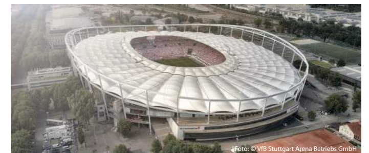
Mercedes-Benz Arena, Stuttgart , energetische Optimierungen der Anlagentechnik im laufenden Betrieb
