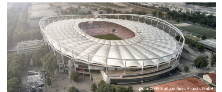
MHPArena, Stuttgart , energetische Optimierungen
