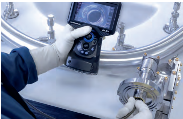
Das Endoskop überprüft die Innenseite von Versorgungssystemen
