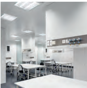
Pharma-Reinräume realisiert von ROM
