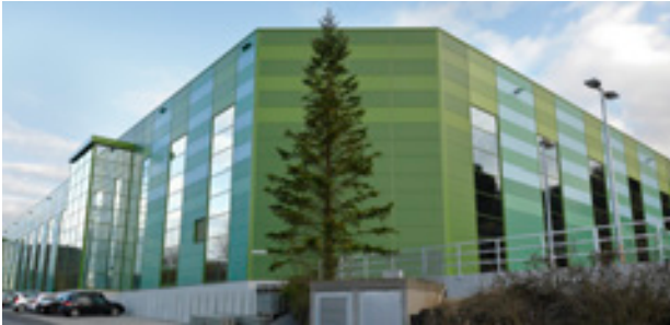
Herman Erkert GmbH Neubau Werk 4
