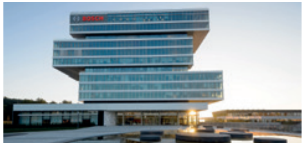
Robert Bosch GmbH Neubau eines Forschungs- und Verwaltungszentrums
