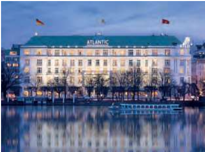
Atlantic Kempinski Hamburg, Umbau & Erneuerung RLT-Anlagen
