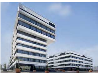
Skylabs Development & Construction, Neubau Büro- & Laborgebäude
