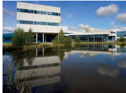
Danfoss Silicon Power, Ausbau Reinraumproduktionsgebäude
